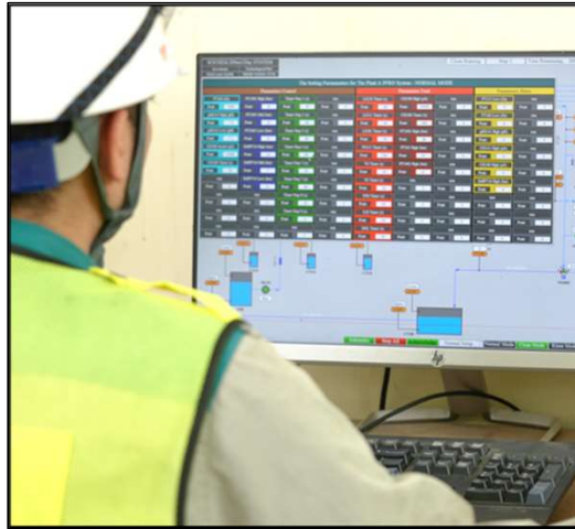
Cán bộ vận hành điều khiển từ xa một hệ thống tái chế
