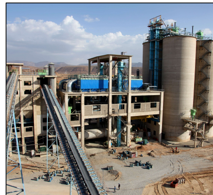
Nhà máy xi măng
