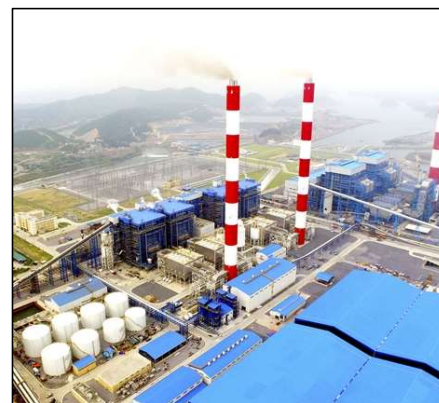
Nhà máy nhiệt điện
